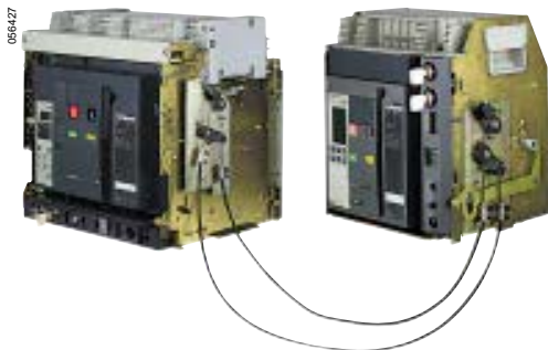
Взаимная блокировка 2 аппаратов Masterpact при помощи тросовых тяг
