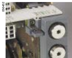
Блокировка вкатывания при открытой дверце
