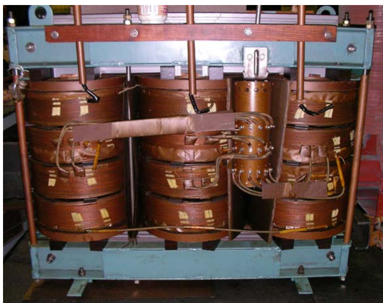
Рис. 1. Магнитопровод силового трансформатора в собранном виде.
