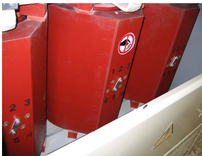
Рис. 2. Обмотки сухого трансформатора с ПБВ.
